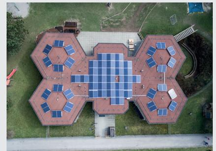
/ „Die PV-Anlage am Kindergarten stellt nicht nur architektonisch eine besondere Herausforderung dar, sondern auch hinsichtlich der Verschaltung (Verstringung) der Module. Immerhin handelt es sich um acht unterschiedliche Ausrichtungen, die an einem MPPT vereint wurden. Dies erweitert den Anwendungsbereich unseres SuperFlex Designs um eine weitere Dimension“, erklärt David Hanek, Produktmanager bei Fronius International.
