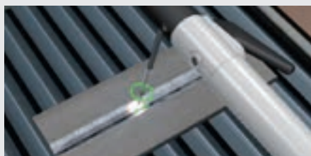
Secuencia de formación de soldadura manual por arco voltaico
