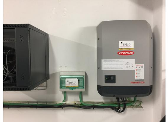
El inversor Fronius Eco sin transformador, con peso ligero y sistema de montaje SnapINverter permite una instalación sencilla y rápida.
