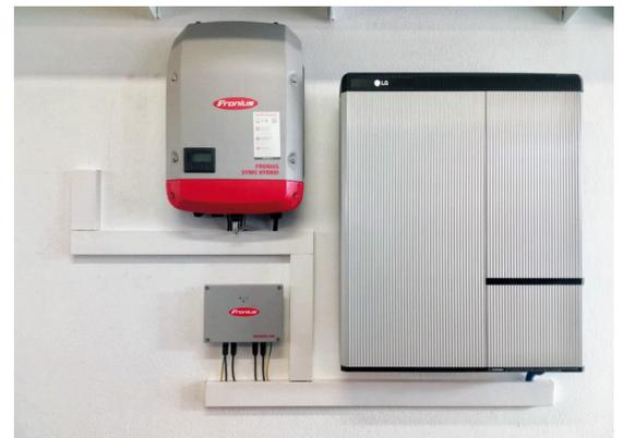
/ La Fronius Checkbox es el dispositivo que protege contra sobretensiones en el sistema
